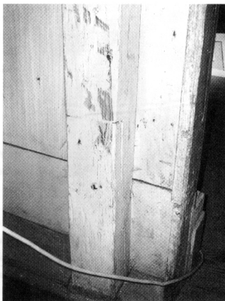
Obr. 8. Litomyšl (okres Svitavy), zámecké divadlo. Rub pravé strany jevištního portálu; nastavení nosného trámu a vložená deska (s ilustrčním mramorováním na lícové straně). (Foto Ondřej Protiva)
