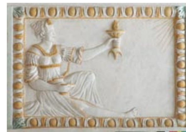
Vstupní sál – štukový reliéf po rehabilitaci modelací a polychromie v roce 2010 (foto J. Waisserová)
