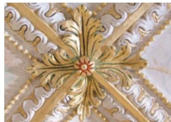
Vladařův pokoj, svorník klenby – po rehabilitaci zlacení a polychromie v roce 2005 (foto J. Waisserová)
